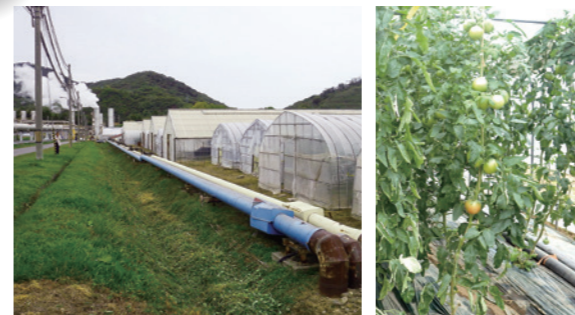
森発電所では、還元熱水と沢水を熱交換することによって得られる85℃の交換熱水をハウス暖房用に給湯し、ブランドトマトとキュウリの生産に役立てています。
