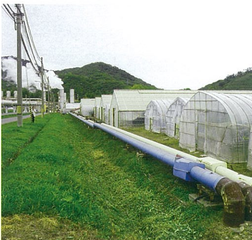
森発電所では、発電に利用した地熱水・高熱蒸気を熱交換することで得られる85度の熱水をハウスに供給し、ブランドトマトとキュウリの生産に一役買っています。
